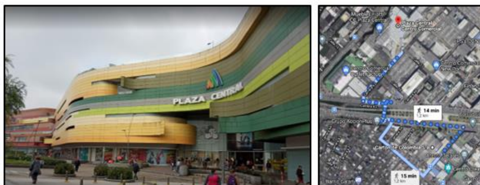
Figura 48. Fotografía del Centro Comercial Plaza Central y localización en el recorrido del trabajo de campo sobre equipamiento en el área de influencia del PPRU Cartón Colombia, octubre 2020
