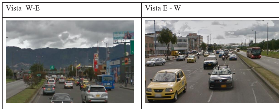
Figura 16. Estado actual de la Av. de Las Américas desde la Carrera 56 hasta la Carrera 58 (costado sur). Fuente: Elaboración propia
