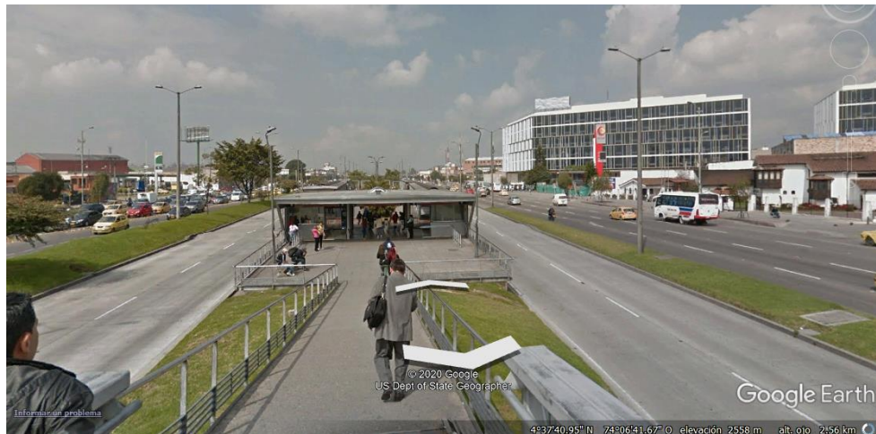
Figura 21. Imagen del Acceso a la Estación de Transmilenio; Américas – Carrera 53 A. localizada al costado oriental del predio. Fuente: Elaboración propia adaptada de una imagen de Google Earth
