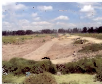
OBRA CANAL SAN BERNARDINO
