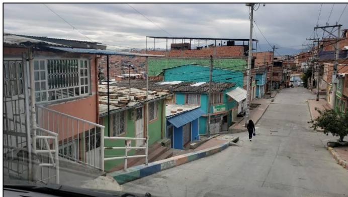
Ilustración 19 Tipología constructiva Sector Potosí vista 1
