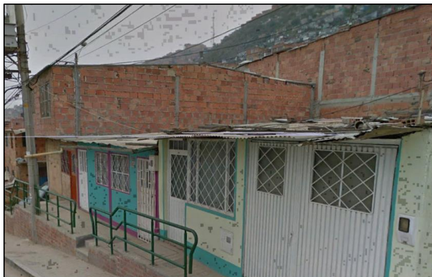
Ilustración 21 tipologías constructivas Sector Caracolí vista 1
