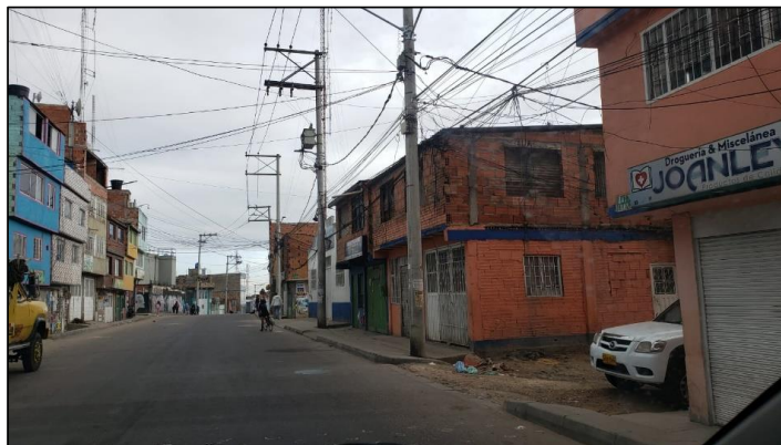
Ilustración 23 tipologías constructivas Santa Viviana vista 1
