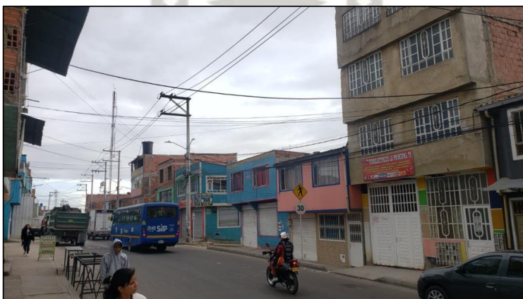
Ilustración 24 tipologías constructivas Santa Viviana Vista 2
