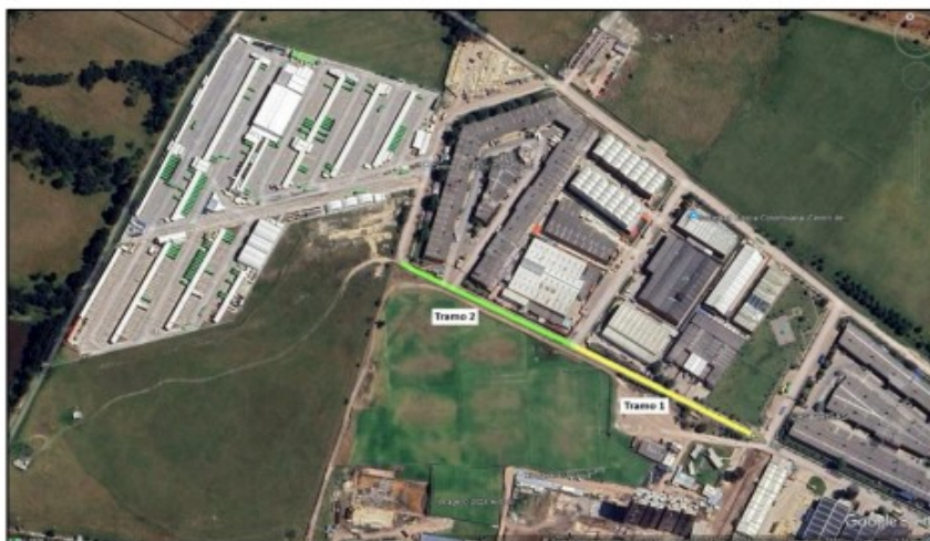
Imagen 1. Tramos viales a intervenir Fuente: elaboración propia a partir de Google Earth.
