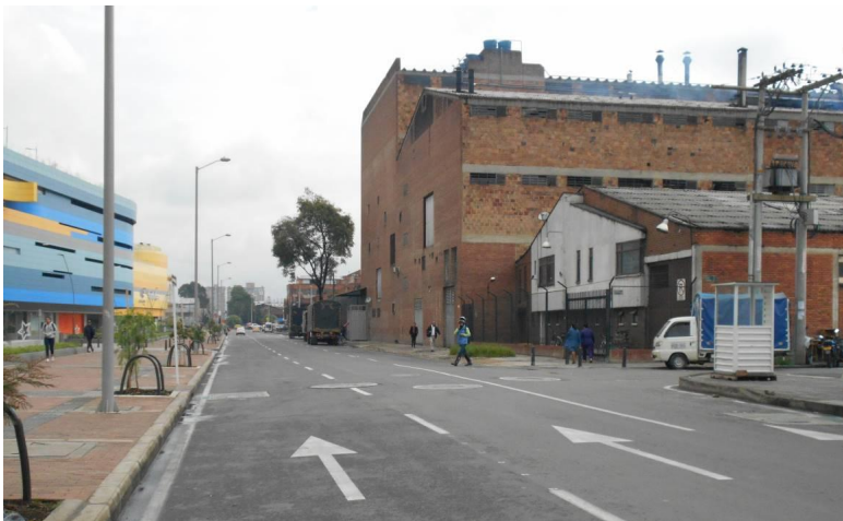
Fotografía 3. Vista de los Predios objeto del PPRU sobre la Carrera 62 Fuente: Consultoría JFM.
