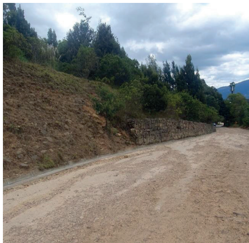
Figura 24. Presencia de unidad geotécnica de piedemonte, sostenidas por gaviones ubicados en paralelo a la vía.
