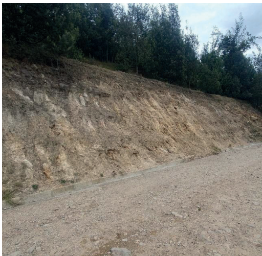
Figura 23. Presencia de unidad geotécnica de roca, aflorando por la construcción de la vía que atraviesa el cerro.
