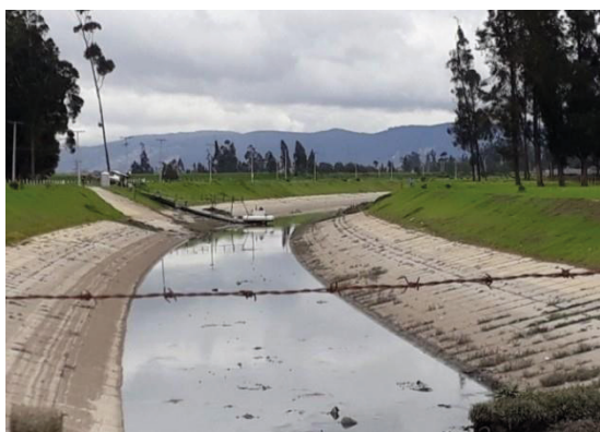
Foto No. 4. Sistema de bombeo Canal Cundinamarca
