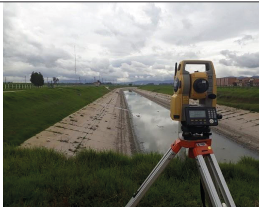
Foto No. 2. Levantamiento topográfico Canal Cundinamarca
