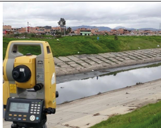
Foto No. 3. Señalización de la corona del canal
