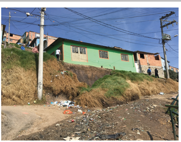
Fotografía 2. Vista frontal del predio evaluado
