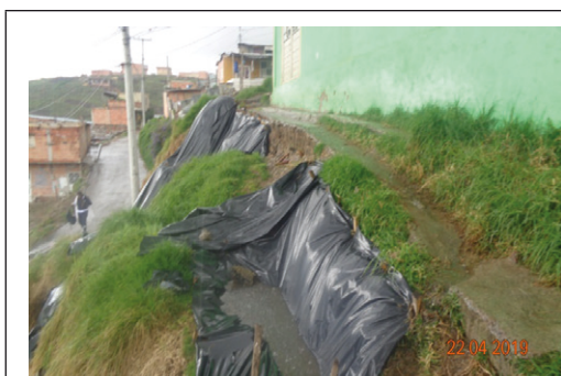
Fotografía No 1 de la adenda No 1 de fecha 22 de abril de 2019 Se observa el cubrimiento del talud con material plástico
